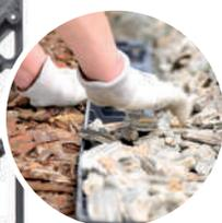
È possibile utilizzare il bordo in alternanza con cordoli in cemento durante la posa di pietre per lastricati, cemento o piastrelle per terrazze da separare o per creare marciapiedi, vialetti e aiuole. I bordi si possono collegare tra loro grazie al sistema di fissaggio integrato; è anche possibile creare un angolo di 90 gradi per recintare alberi, arbusti, prati e aiuole, dopo aver tagliato la fascia tecnica posteriore.
